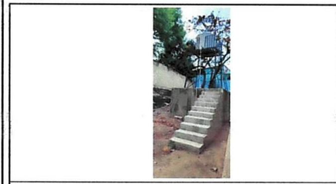
Foto1: habilitacion de tanque de concreto para almacenar agua y colocacion de bomba hidroneumatica para tanque elevado y aumentar el caudal de agua del Instituto
